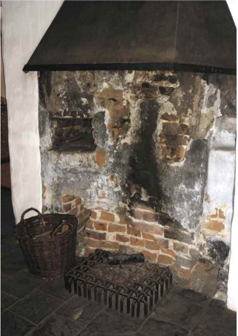
Abb. 5: Historische Feuerstelle mit Backnische von 1650; davor Sandsteinplattenboden
